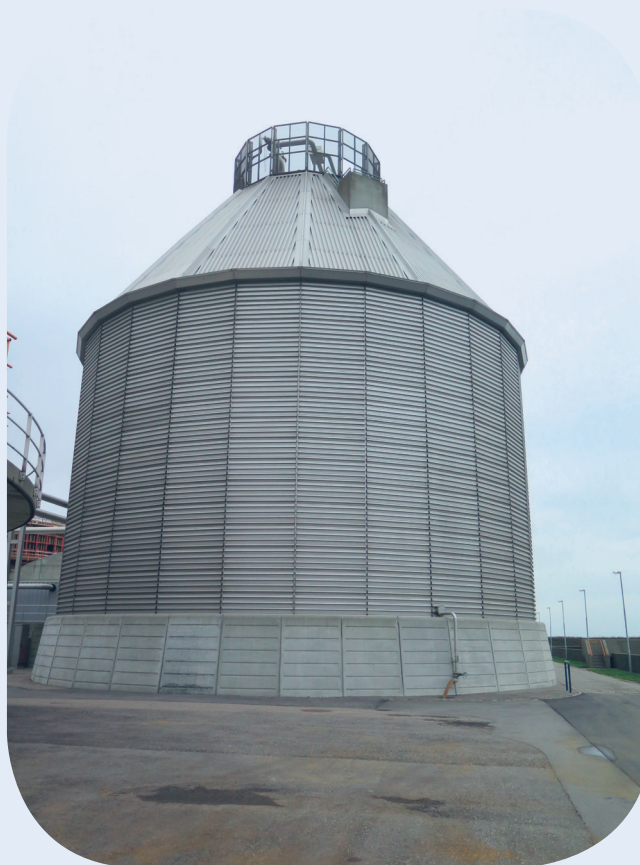
En af de kæmpemæssige rådnetanke på Lynetten. Det er her slammet nedbrydes samtidig med, der bliver dannet biogas.
